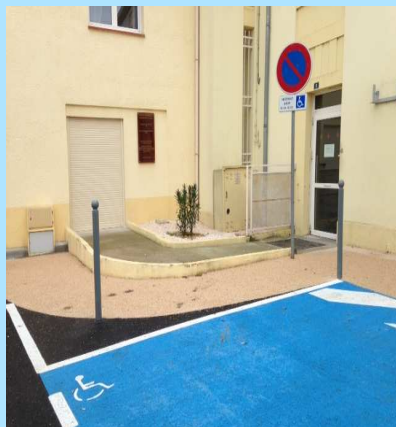
Le devant de la crèche après les travaux
