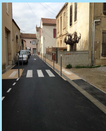
Rue Emile Zola après réfection de la chaussée
