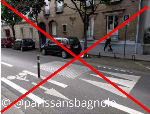
Les coussins berlinois sont pénalisants pour les vélos, notamment avec remorques. Ils doivent respecter le coefficient de rugosité préconisé par le Cerema (0,45) pour éviter les glissades en cas de pluie. L'utilisation est possible lorsqu'il n'y a pas d'autre solution pour ralentir les véhicules motorisés.
