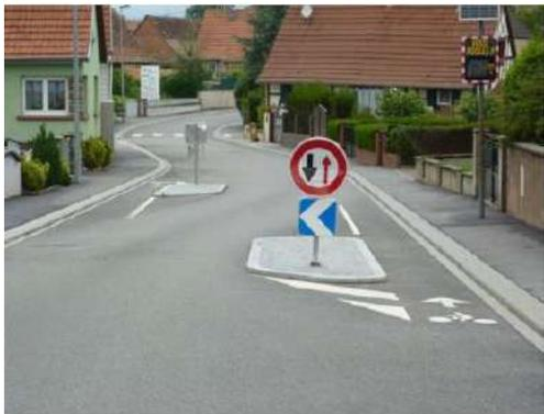
En cas d'implantation d'écluses ou d'autres dispositifs de rétrécissement de la chaussée, prévoir de conserver un « bypass » vélo de 1,5 m de large minimum. Ces by-pass doivent être courts pour ne pas créer un effet tunnel. Pour les écluses, les plots sont à proscrire (utiliser si nécessaire des balises J12 de protection).
